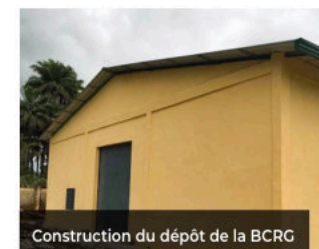
Construction du dépôt de la BCRG
